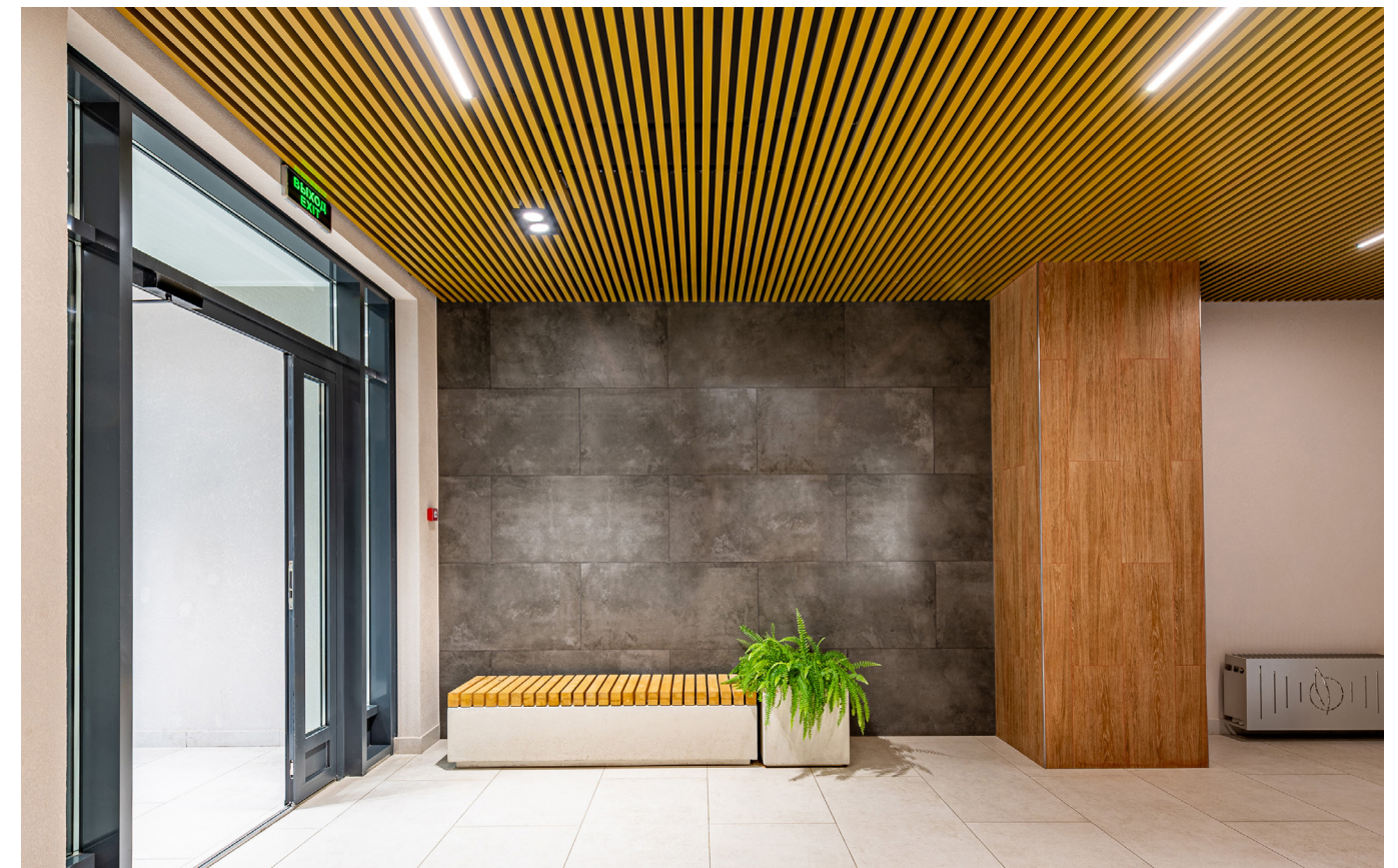
Кубота, RAL 1036 Al, ширина рейки 30 мм \ высота рейки 39 мм
