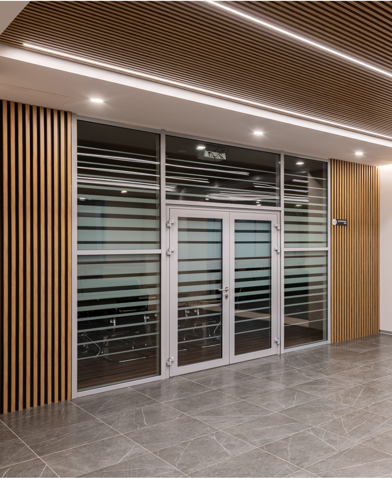
Кубота, Honey Wood Al, ширина рейки 30 мм \ высота рейки 40 мм
