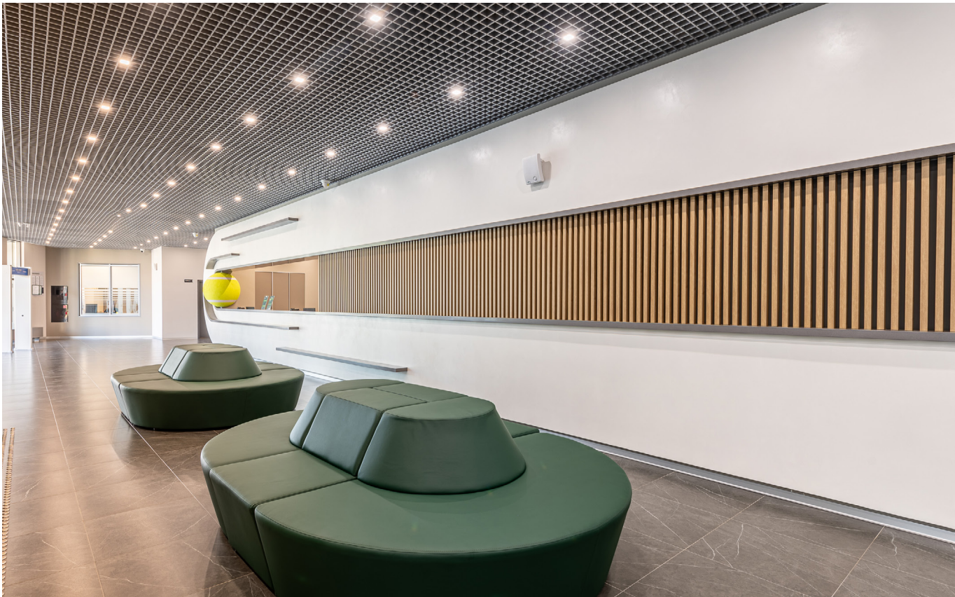
Кубота, Honey Wood Al, ширина рейки 30 мм \ высота рейки 40 мм Грильято Модульный GL-15, RAL 9003 Zn, размер ячейки 50x50 мм, высота профиля Standart 38 мм Подвесная система Slim T-15, RAL 9003 Zn
