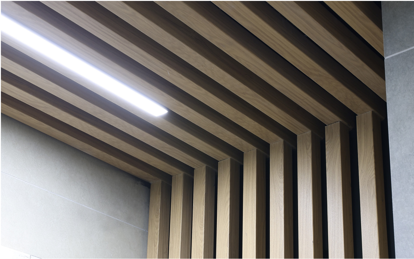
Кубота, Honey Wood Zn, ширина рейки 50 мм \ высота рейки 50 мм
