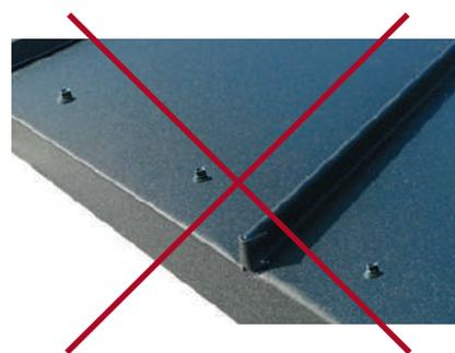
Установите длинные крюки для крепления желоба водостока в соответствии с рекомендациями производителя. Утопите крюки в обрешетку, чтобы они не мешали монтажу Карнизной планки и панелей.
