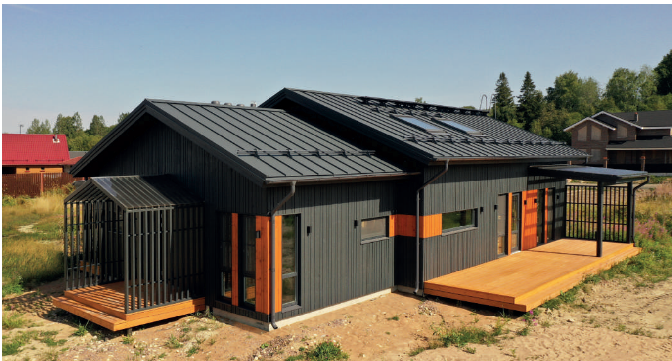
Кликфальц® Satin Matt RAL7016, водосток металлический Grand Line 125/90 мм, снегозадержатели для фальцевой кровли Grand Line. Объект АртСтрой
