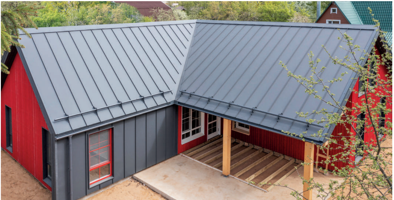
Кликфальц® Pro Satin RAL7024, водосток металлический Grand Line 125/90 мм, снегозадержатели для фальцевой кровли Grand Line. Объект Fin.House
