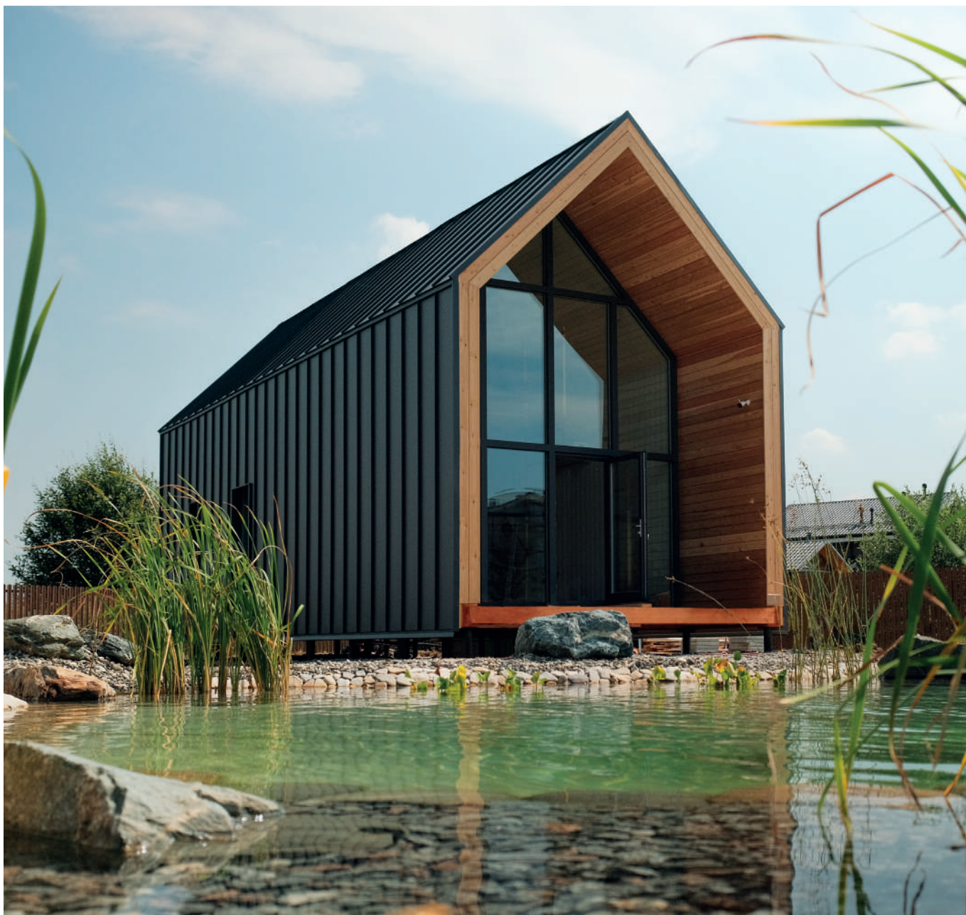
Кликфальц® Pro Rooftop Бархат RAL7024. Объект ОКprefab
