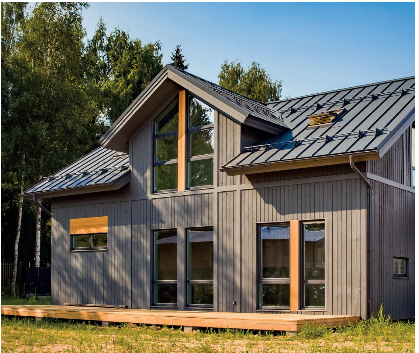
Кликфальц® Pro Line Rooftop Бархат RAL7024, водосток металлический Grand Line 125/90 мм, снегозадержатели для фальцевой кровли Grand Line. Объект Izburg
