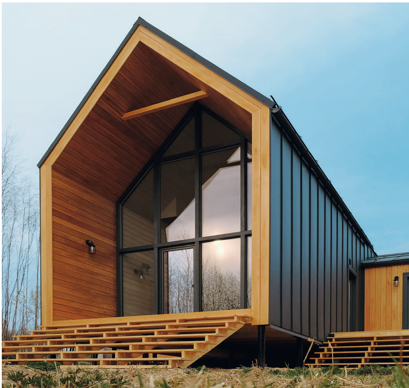
Кликфальц® Rooftop Бархат RAL7024. Объект ОКPrefab
