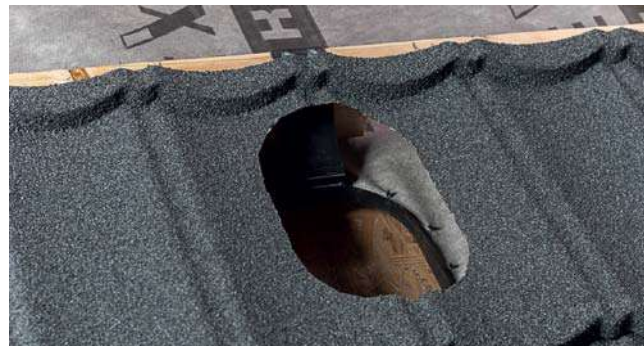
Рис. 39 а. Проходной элемент (DECRA) для панели Classic
