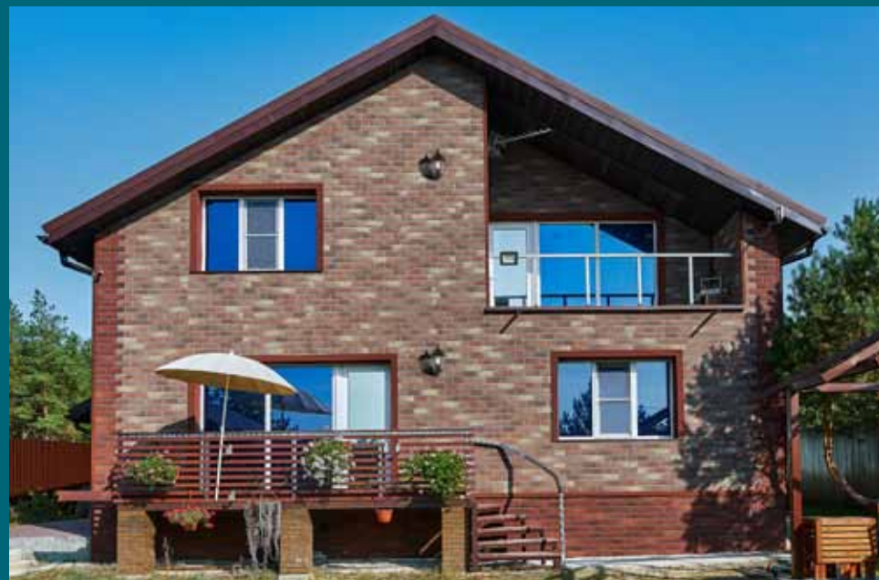
Объект «ПОСЛЕ». Коллекция КИРПИЧ, цвет Английский кирпич
